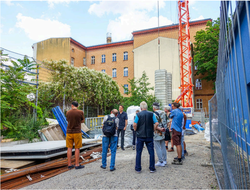
Baustellenbegehung am 16. Juli. Fotos (2): Sulamith Sallmann
