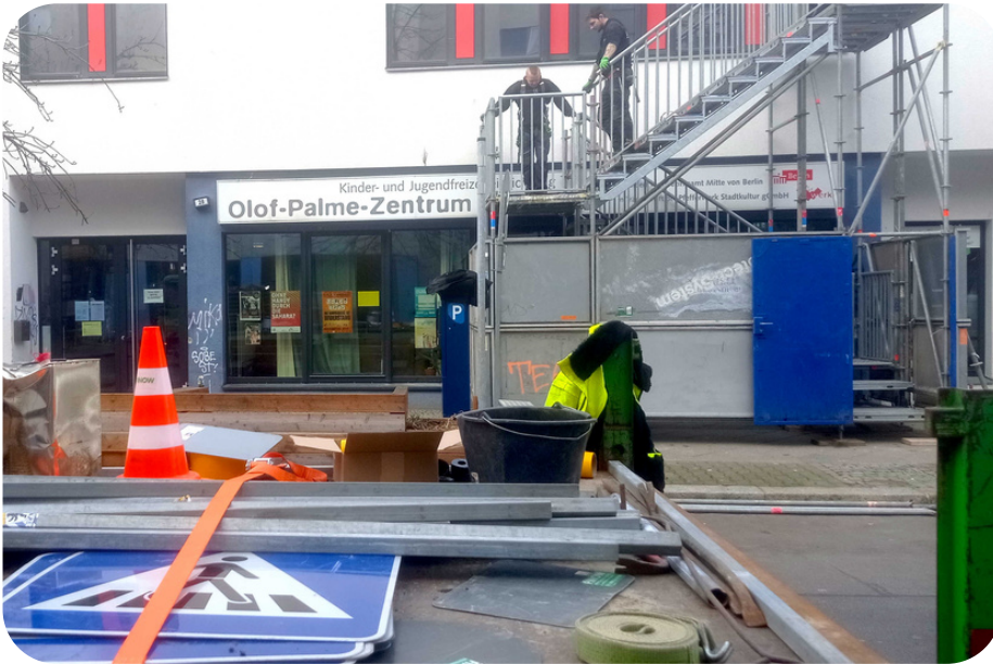
Feuertreppe und zwei neue Zebrastreifen vorm OPZ. Fotos: C. Schumacher (2), J. Uhländer
